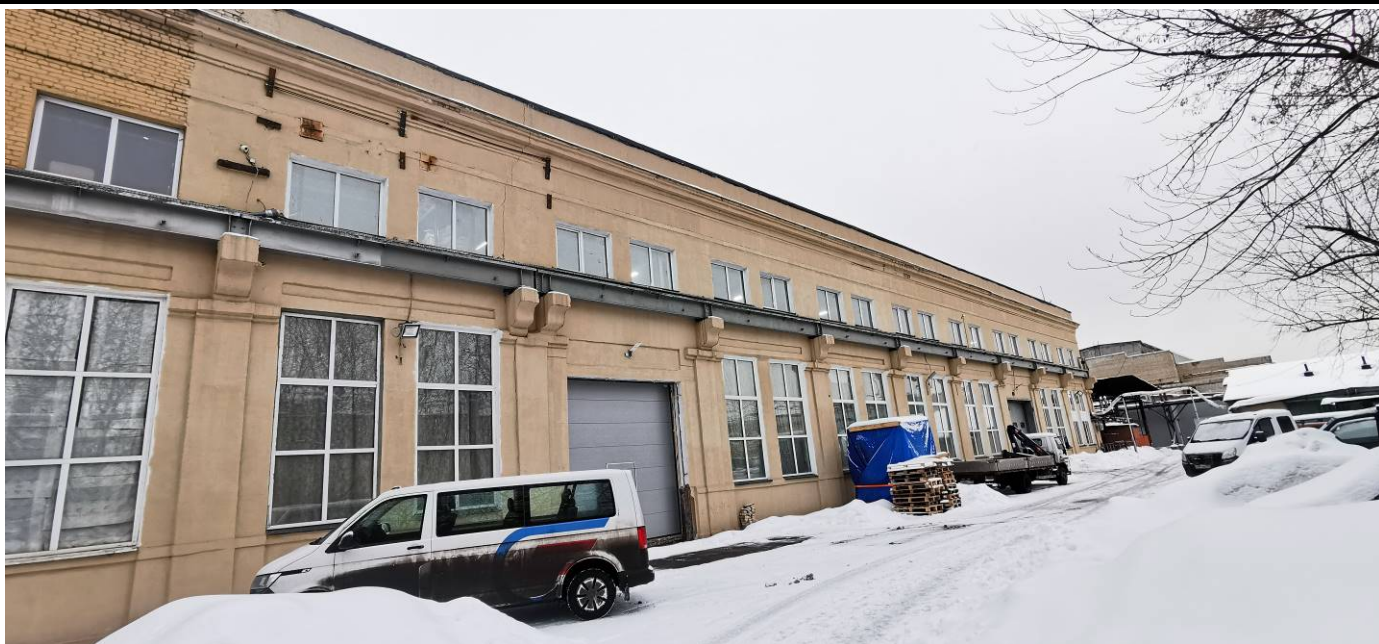
Рис. 1.1 Фасад здания в осях 1-10/А
