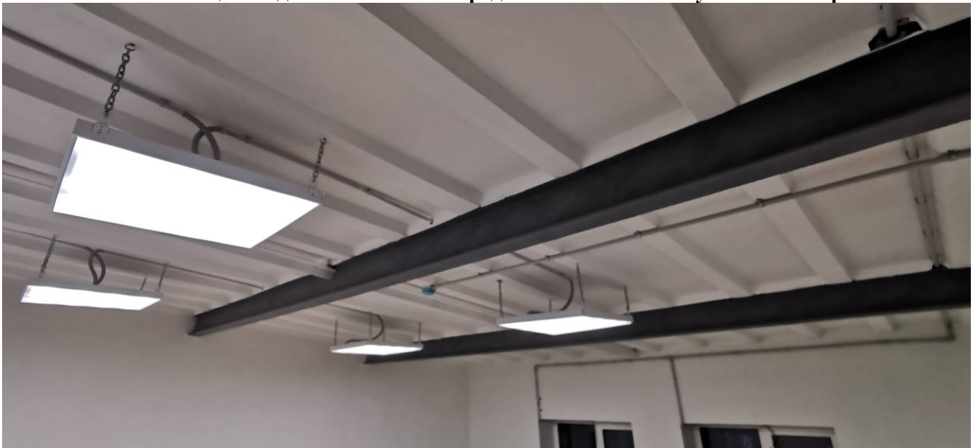
Рис. 3.2.14 Общий вид покрытия из балок в осях 11-12/В-Д
