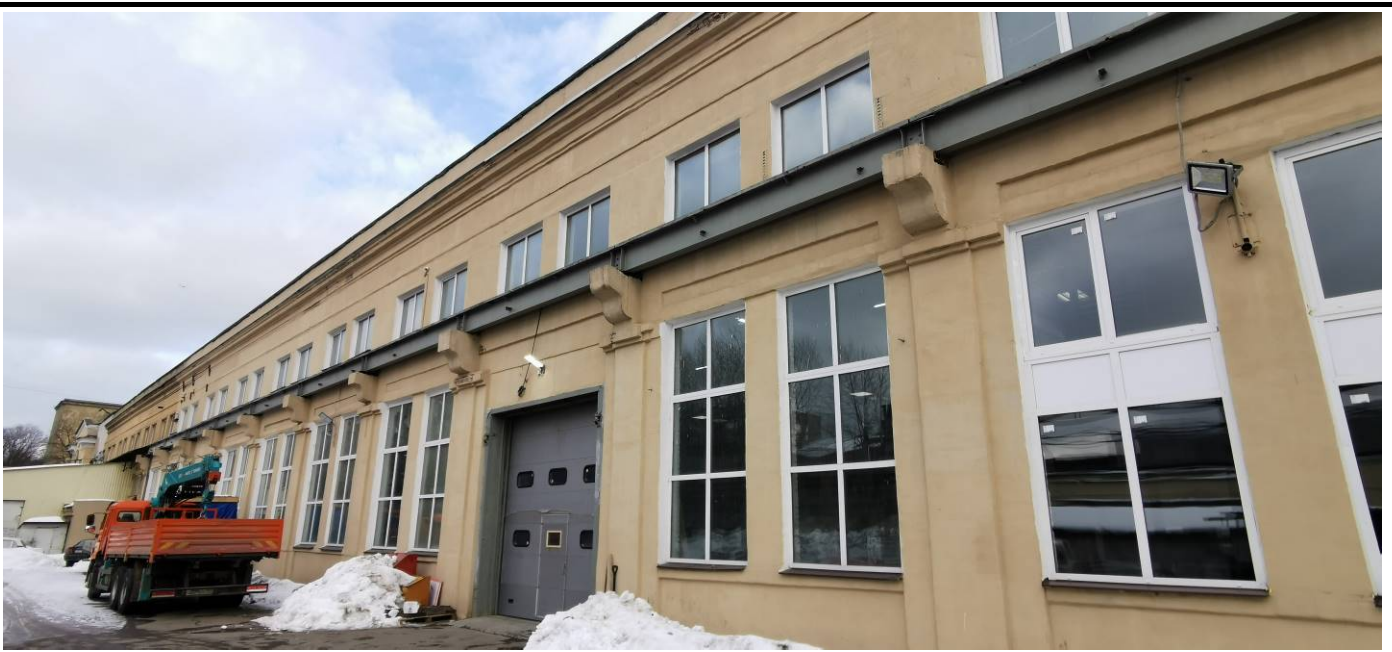
Рис. 3.1.1 Общий вид наружных стен со стороны улицы в осях 1-9/А
