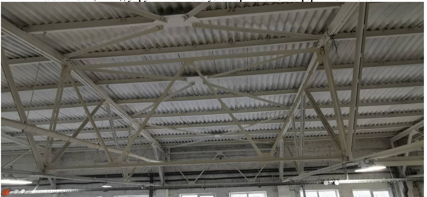
Рис. 3.2.8 Общий вид ферм типов ФС-2, ФС-3
