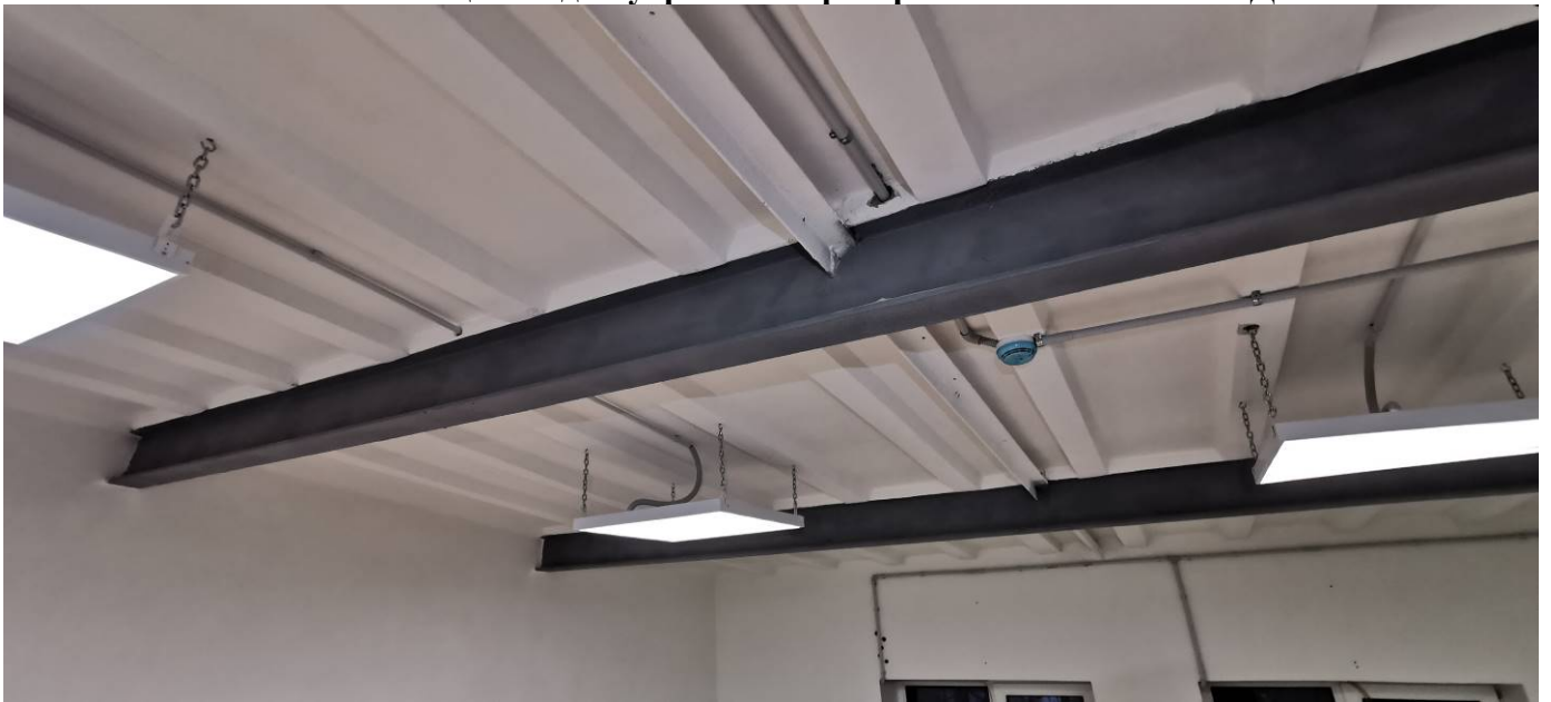
Рис. 1.5 Общий вид покрытия из балок в осях 11-12/В-Д
