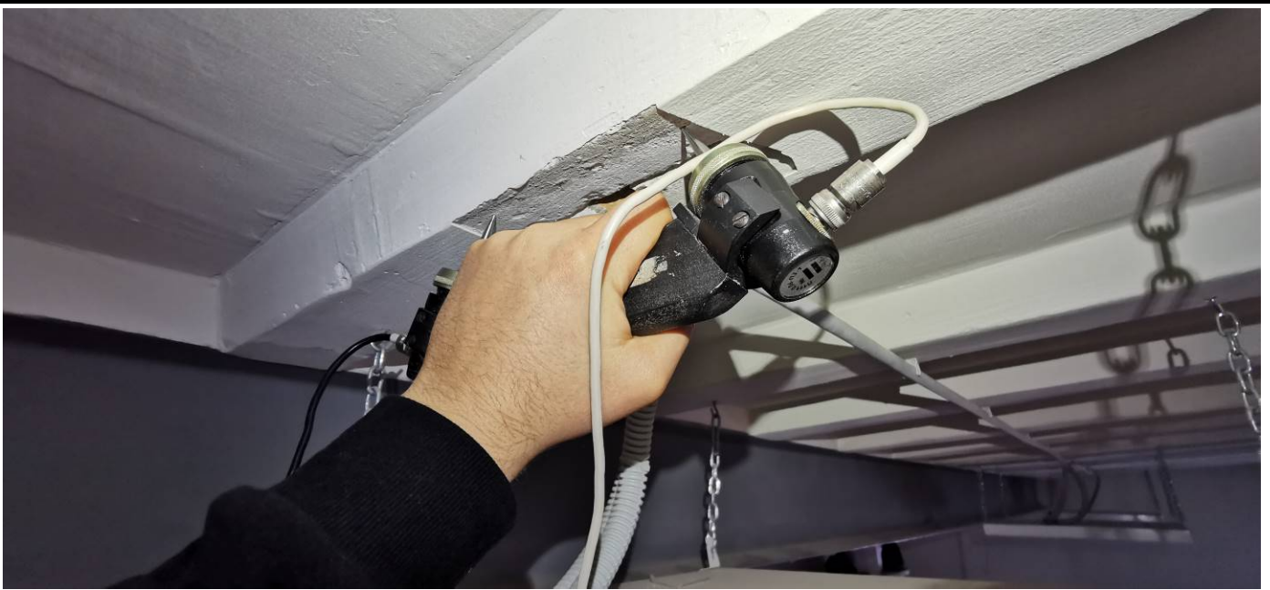
Рис. 4.2.1 Общий вид определения скорости ультразвука плит покрытия в осях 11-12/А-Д
