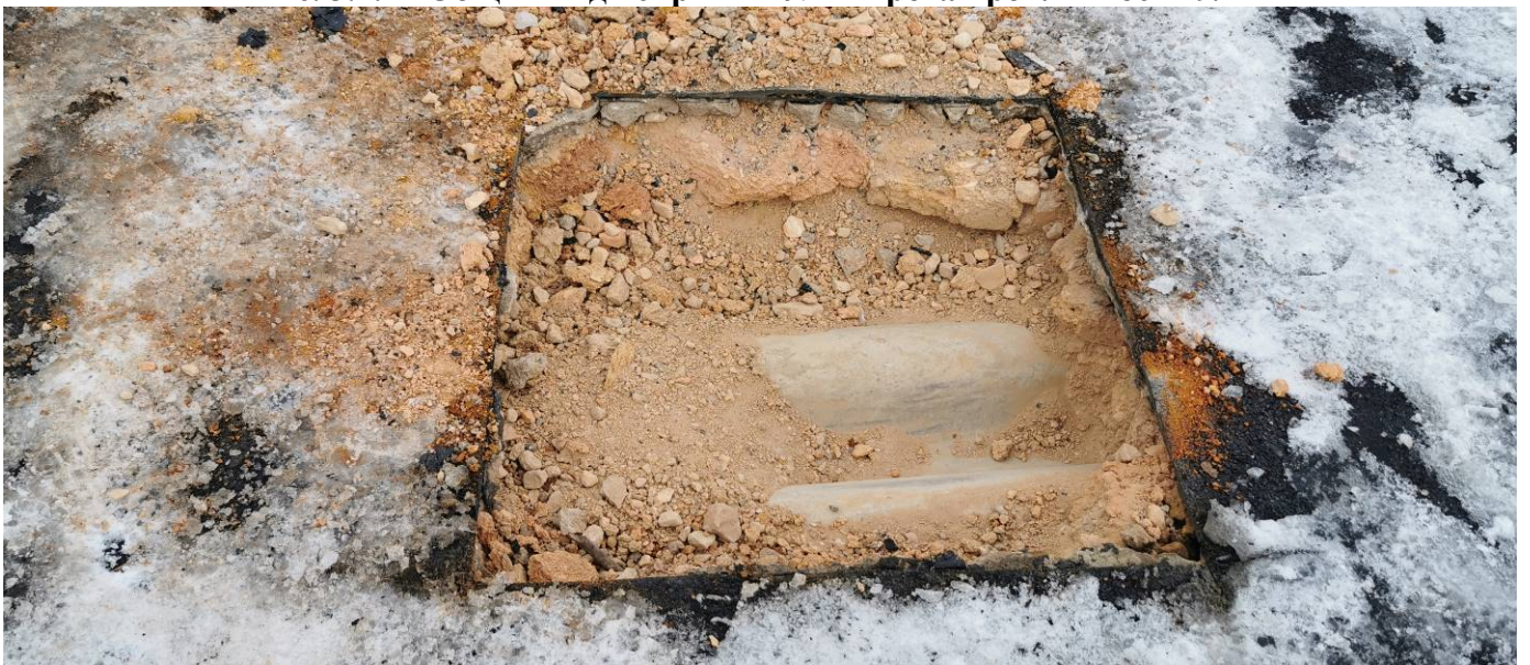
Рис. 3.2.12 Общий вид вскрытия №2 пирога кровли в осях 9/В
