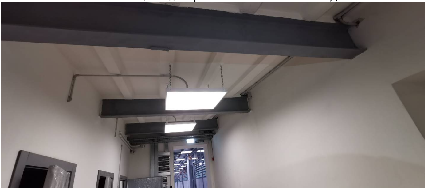
Рис. 1.6 Общий вид покрытия из балок в осях 11-12/В
