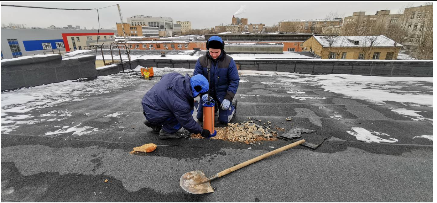
Рис. 3.2.13 Общий вид испытаний по определению плотности утеплителя кровли.
