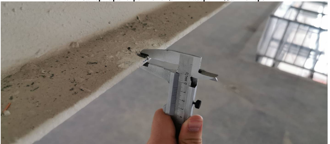
Рис. 2.3 Замер элементов металлических конструкций штангенциркулем
