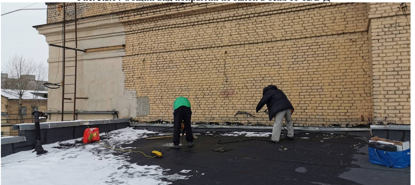
Рис. 3.2.15 Общий вид кровли здания в осях 11-12/Б-Г
