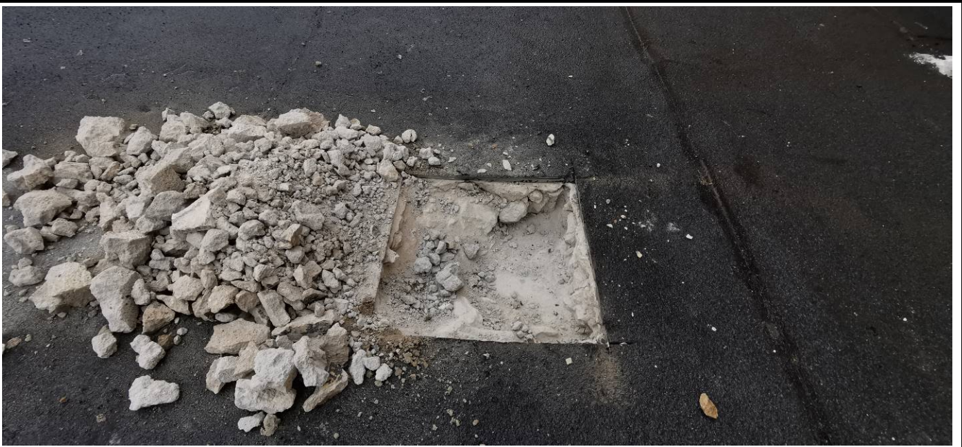
Рис. 3.2.16 Общий вид вскрытия кровли №3 в осях /Б
