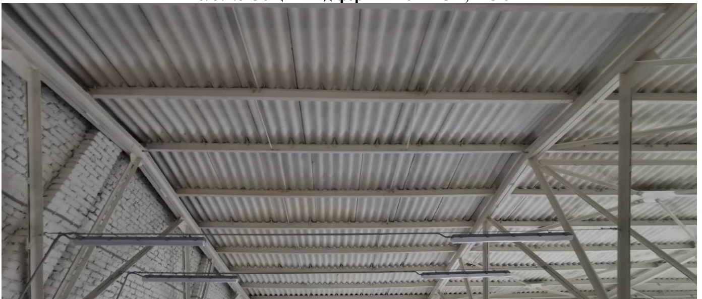
Рис. 3.2.9 Общий вид прогонов и настила из хризотилцементных листов
