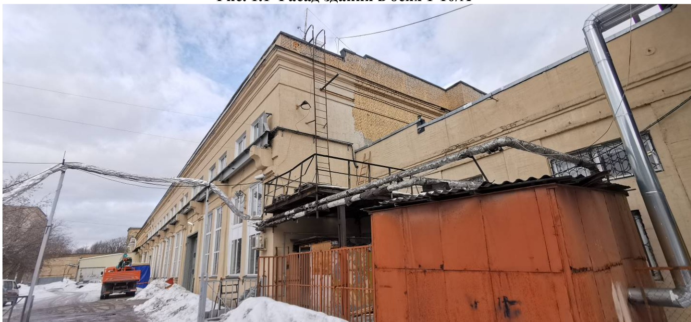
Рис. 1.2 Фасад здания в осях 11/А-В
