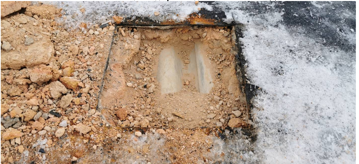
Рис. 3.2.11 Общий вид вскрытия №1 пирога кровли в осях 9/А
