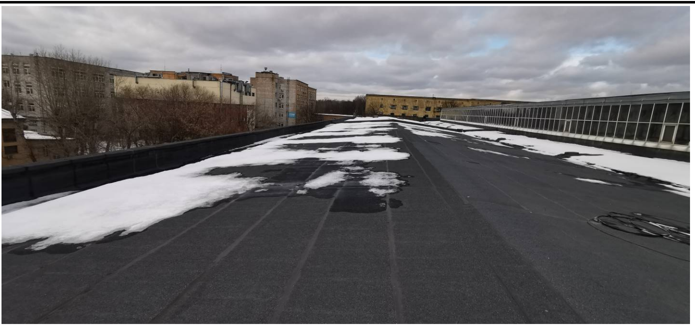
Рис. 3.2.10 Общий вид кровли здания в осях 1-10/А-Д
