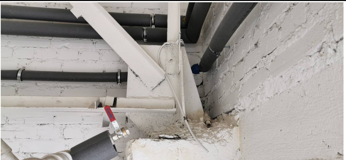
Рис. 3.2.4 Общий вид опирания нижнего пояса ферм типа ФС-1 вдоль оси А
